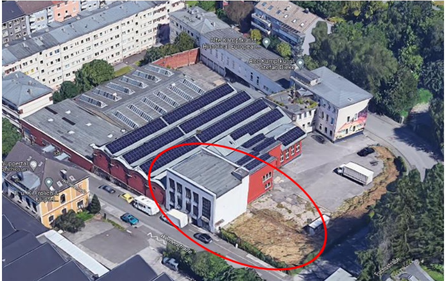
Geländeansicht von oben/ Quelle: googlemaps
