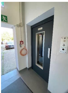
barrierefreier Zugang Aufzug-Bereich Untergeschoss
